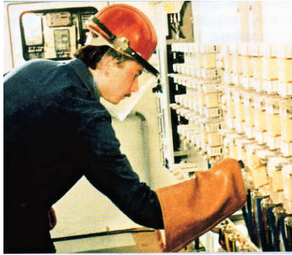
شکل ۱۲،۱ - جایگزینی و کار کردن با فیوزهای NH در زیر بار
